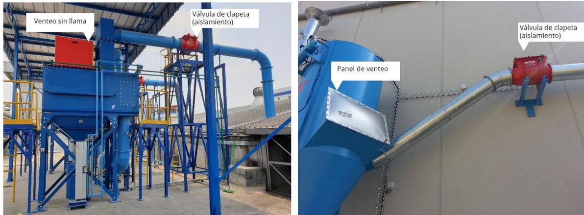
*Fig. 5. Sistemas de protección en filtros de mangas*
