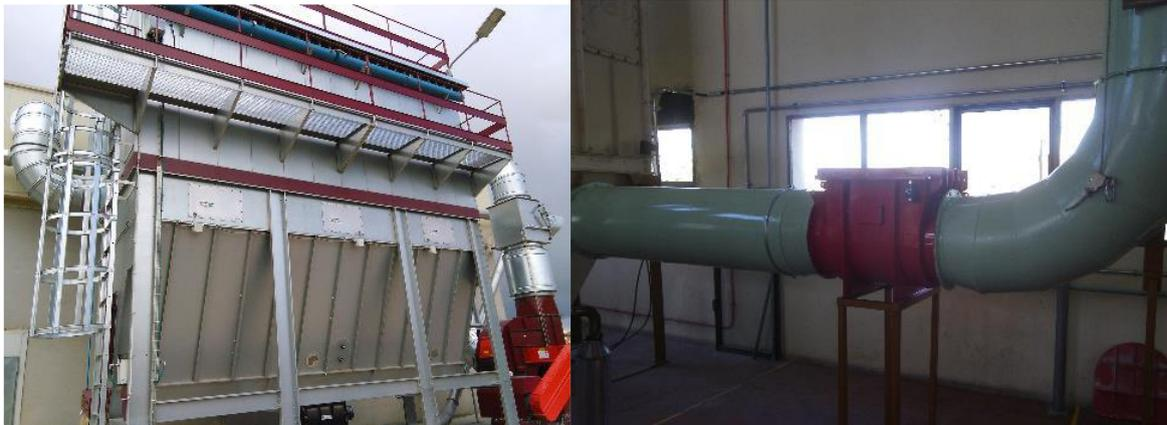
Fig. 4. Sistemas de protección en filtros de mangas (fuente: ADIX)
