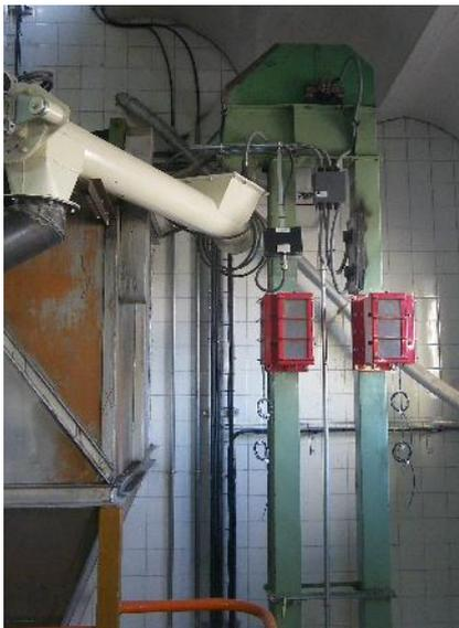
Abb. 3. Flammenlose Entlüftung im Werk
