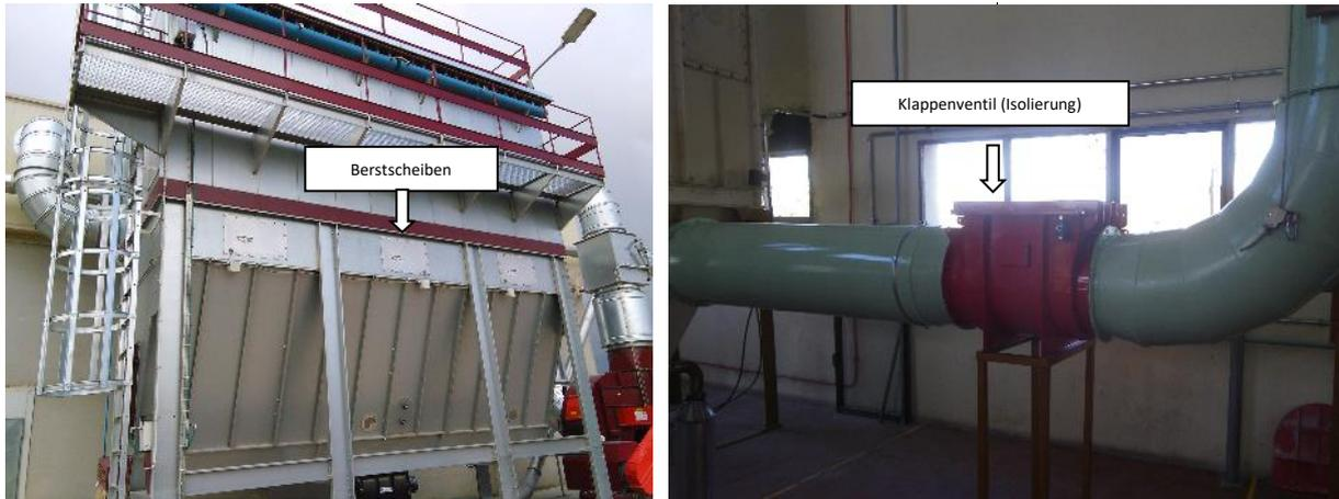
Abb. 2. Schlauchfilter-Schutzsysteme
