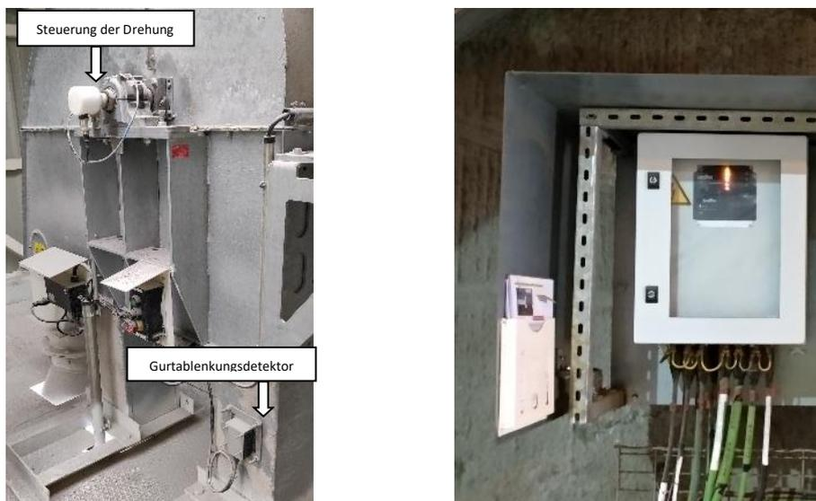
Abb. 1. Zündquellensteuersystem für Gurtbecherwerke (Spyline ADIX)
